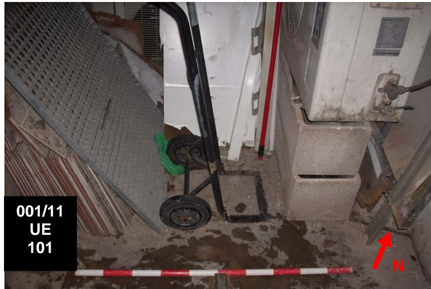
Paviment actual UE 101
