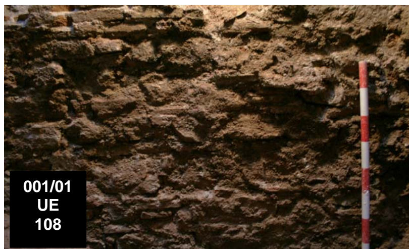
Detall banqueta de fonamentació UE 108
