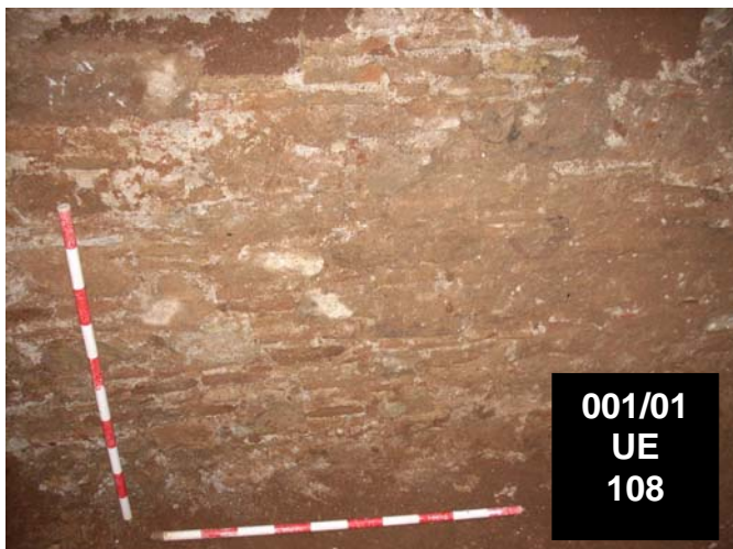
Perfil sud. Banqueta de fonamentació UE 108
